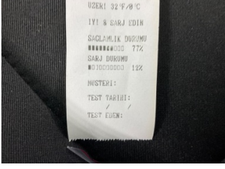
Elektrik donanımı/Pano, Akü > Test Sonucu
