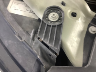
Farlar, Far bağlantı ayağı, sağ > Hasarlı
