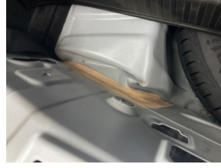
Arka bölüm, Bagaj havuzu > Hasarlı
