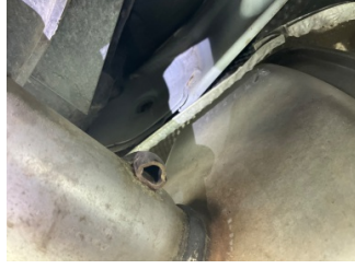
Arka bölüm, Arka sac/panel > Hasarlı
