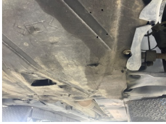
Motor, Alt muhafaza > Hasarlı
