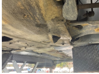
Motor, Alt muhafaza > Hasarlı
