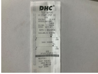
Elektrik donanımı/Pano, Akü > Test Sonucu
