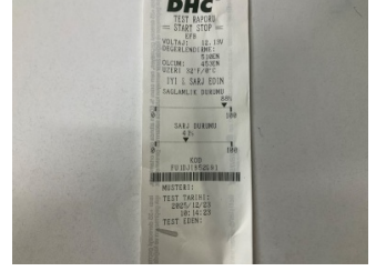
Elektrik donanımı/Pano, Akü > Test Sonucu
