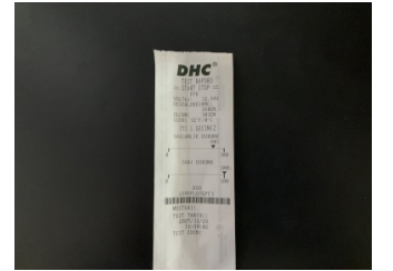
Elektrik donanımı/Pano, Akü > Test Sonucu
